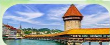
สะพานไมซ์าเปิล
