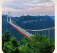
สะพานอ้ายจ้าย
